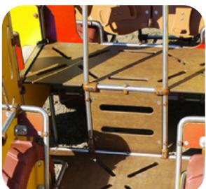
Des **planchers en HPL** (stratifié massif haute pression), **particulièrement résistant** (épaisseur 14mm), imputrescibles, difficilement inflammables fixés sur un cadre métallique.
