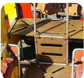
Des **planchers en HPL** (stratifié massif haute pression), **particulièrement résistant** (épaisseur 14mm), imputrescibles, difficilement inflammables fixés sur un cadre métallique.
